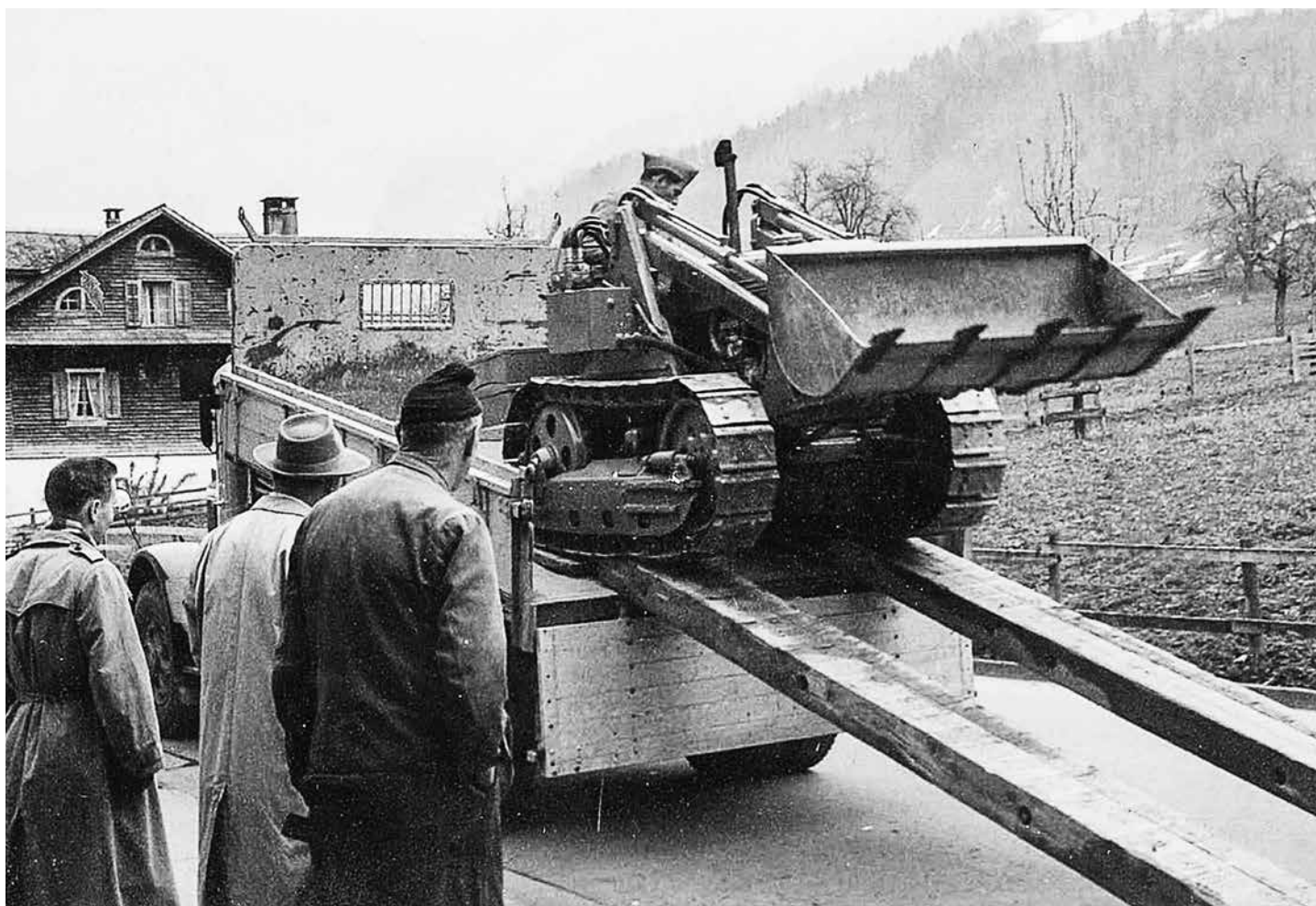
Photo en haut 1955: premier trax hydraulique entièrement
